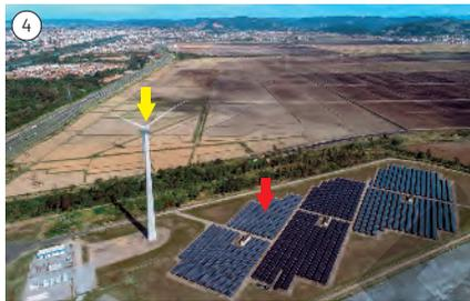
Exemplo de usina de geração elétrica a partir de fontes **renováveis**, que utiliza gerador eólico (indicado pela seta amarela) e geradores fotovoltaicos (indicados com a seta vermelha). (Tubarão, SC, 2021.)
