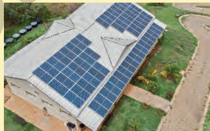
Células fotovoltaicas captam energia luminosa do Sol e a convertem em energia elétrica, representando uma boa alternativa para gerar energia elétrica em locais ensolarados. Placas solares são constituídas por diversas células fotovoltaicas e podem ser instaladas no telhado de edificações. (Na foto, placas solares em prédio do Jardim Botânico de Sorocaba, SP, 2020.)
