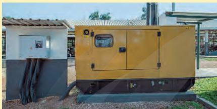
Gerador elétrico de emergência a diesel, que transforma energia potencial química do combustível em energia cinética (movimento do gerador) e esta, por sua vez, em energia elétrica. (Carambei, PR, 2019.)
