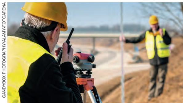
Apoiada no tripé, a luneta permite que um observador,  $O$ , mire um referencial,  $A$ , após o que o teodolito indica a medida  $\theta$  do ângulo agudo que o segmento  $\overline{OA}$  forma com o plano horizontal.
